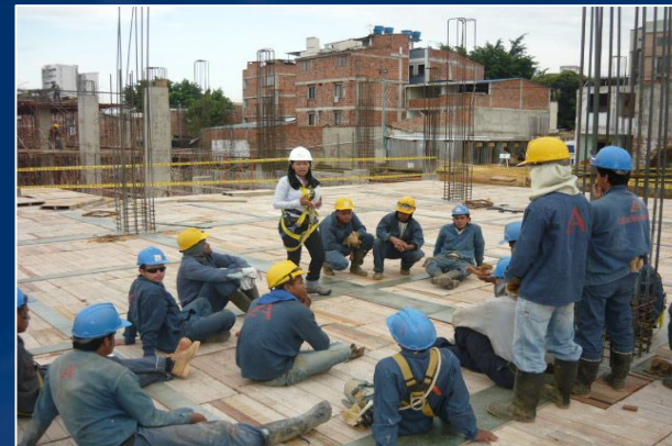
Obra Homecenter Bucaramanga
