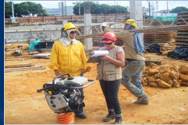
Obra Homecenter Bucaramanga
