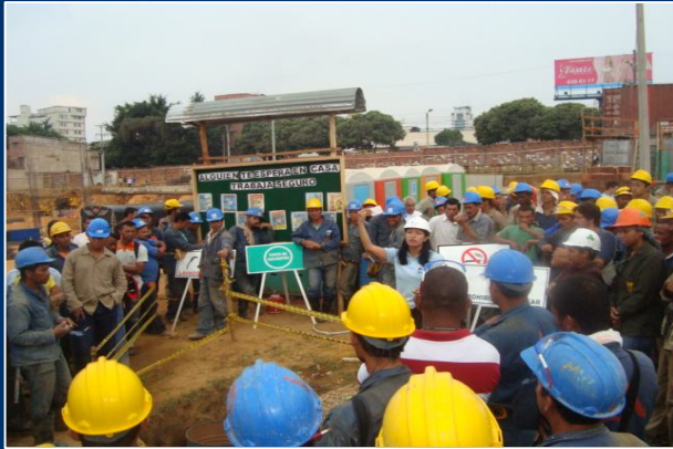
Obra Homecenter Bucaramanga
